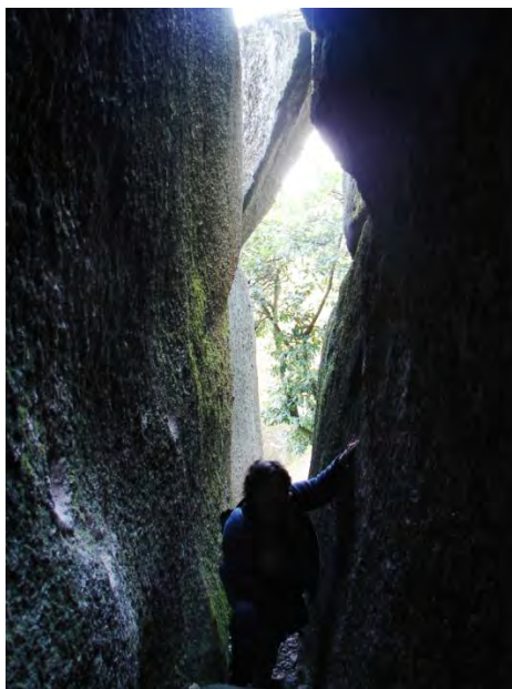
Figura 5.132 – Aparência de uma das grandes fendas formadas a partir da meteorização do granito.
