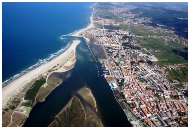
Figura 13 - Vista Aérea de Esposende
